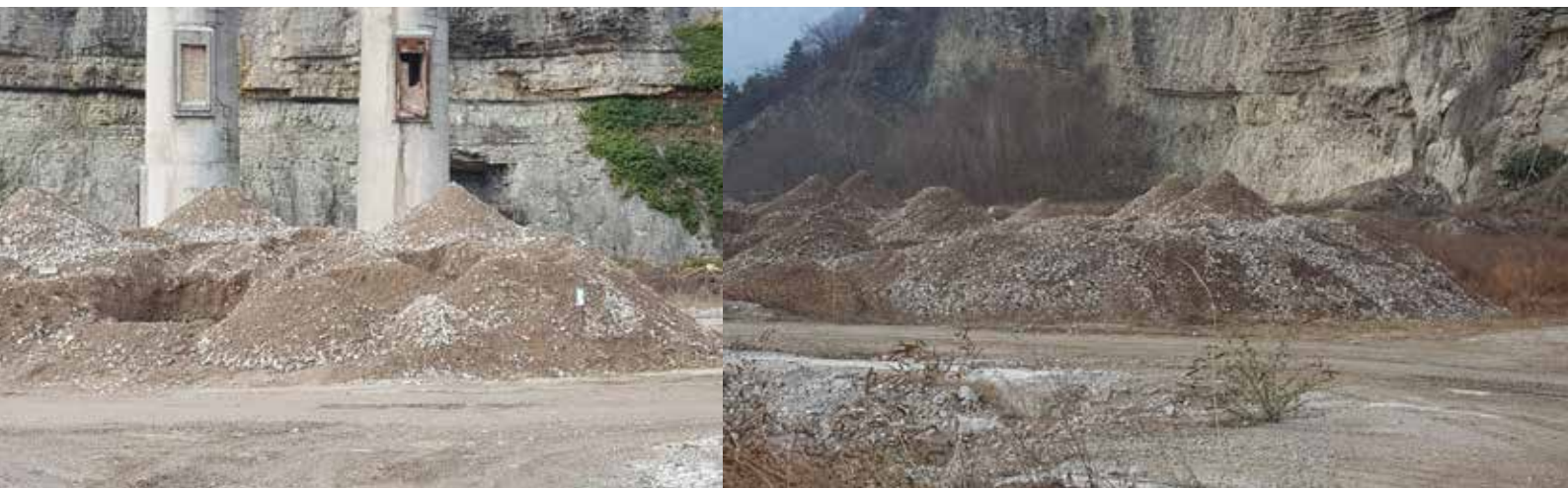
I lavori di bonifica dell'area ex Italcementi.
